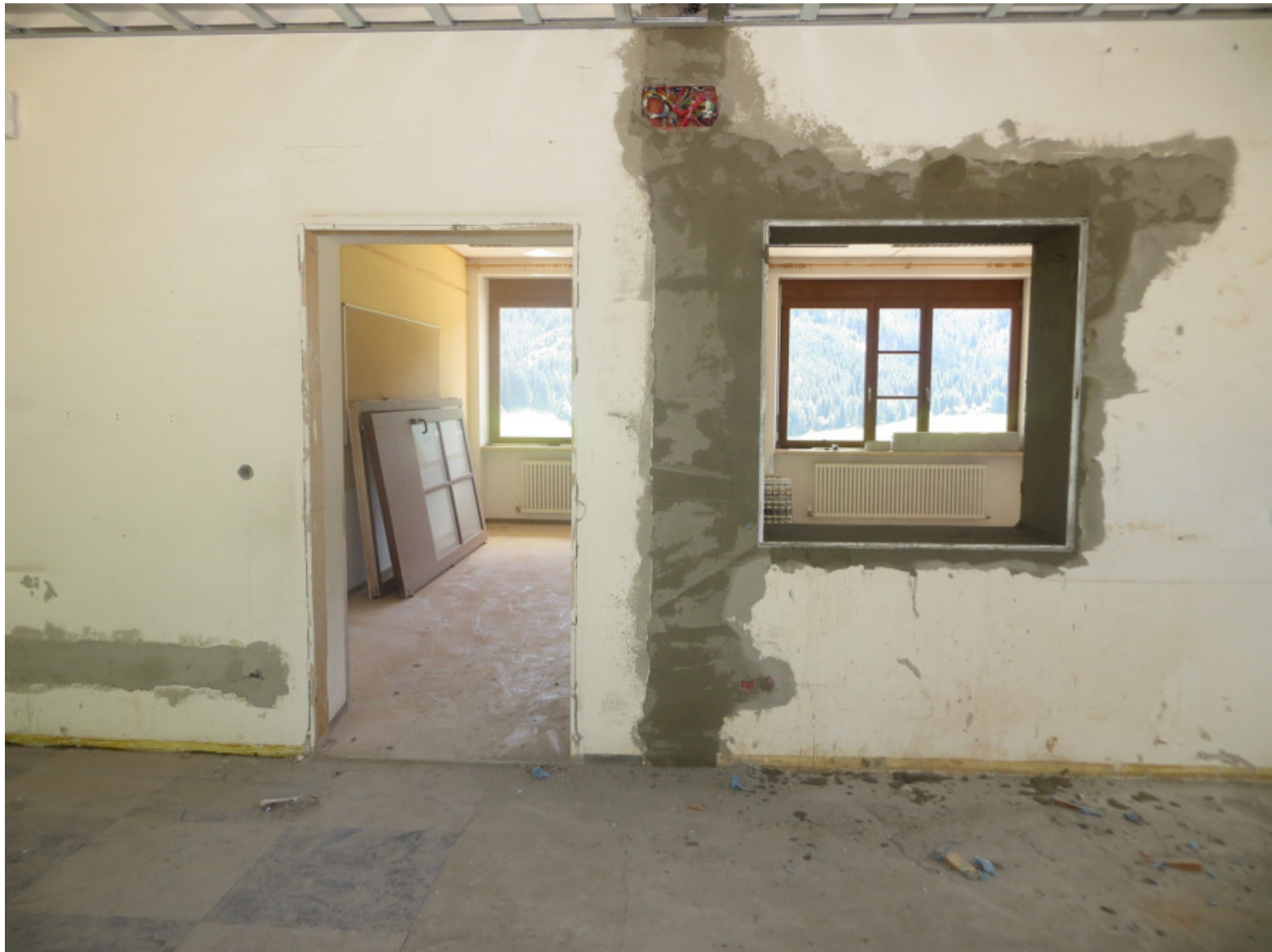
Die Wände zu den Klassen hin wurden aufgebrochen – damit entstanden Sichtverbindungen zwischen den Klassenräumen und den Lernwerkstätten.
