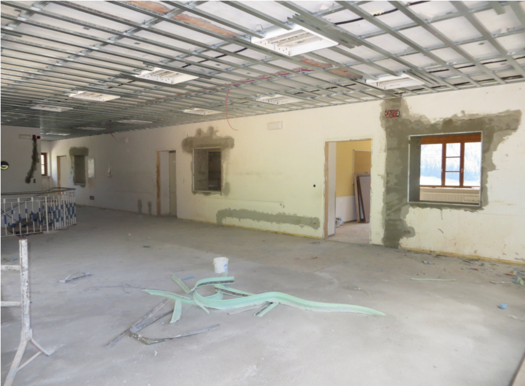
Die Decken wurden mit Akustikplatten verkleidet.
