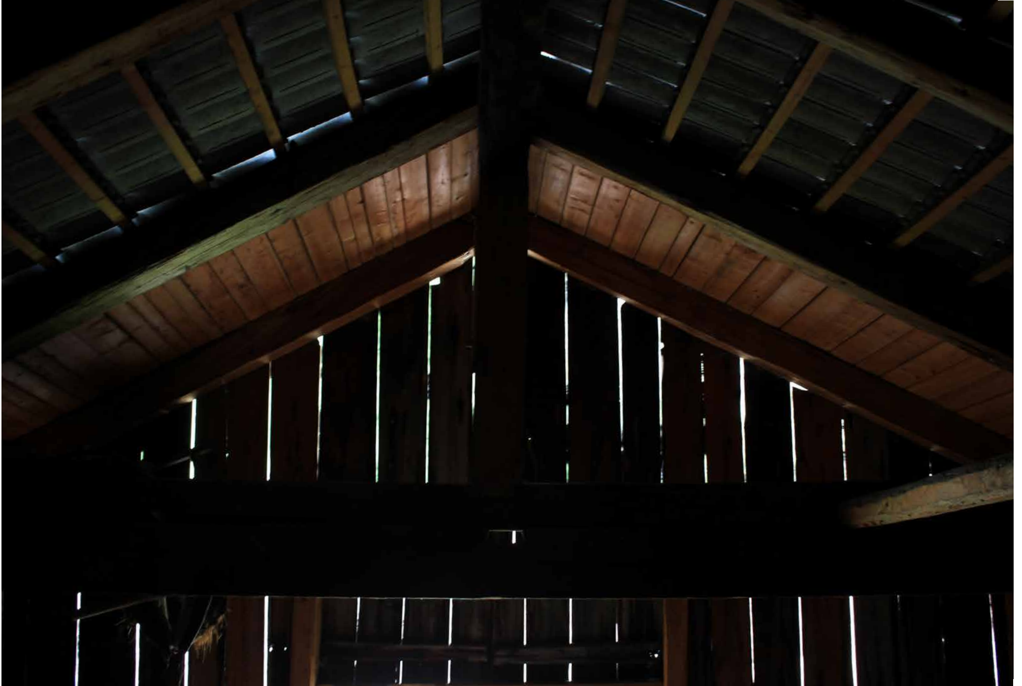
Zusammenfassung „UNTER DEM DACH DES BURGER HOFES“ Gestaltungsworkshop Mittelschule Paul Troger, Welsberg Klasse 2B 24.-28.10.2016
