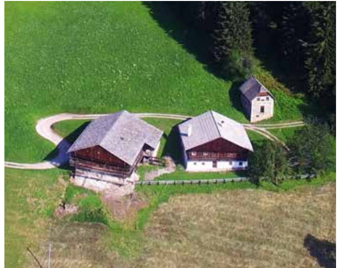
Burger Hof vor Beginn der Sanierungsarbeiten
